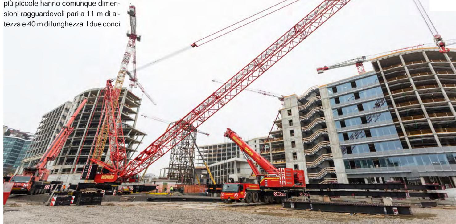
zione corretta. Partendo dal lato più pesante, i concetti sono stati posizionati sulla soletta superiore del Landmark e sono andati a poggiare su una falsa pila appositamente costruita. I due concetti più piccoli sono stati posti tra la falsa pila e l'edificio Icon. A questo punto i vari tronconi sono stati imbullonati e poi si è proceduto allo smontaggio della falsa pila. Tanti i mezzi Autovictor impegnati in cantiere. Oltre alla Terex Demag TC 2800/1, che ha
